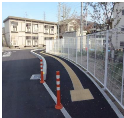
歩道設置(市道)
