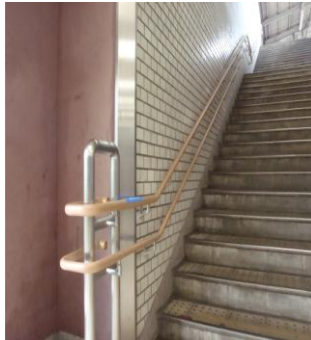
2段手摺の設置
