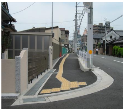
歩道設置(市道)
