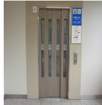
エレベーターの設置
