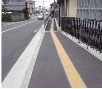
歩道設置(市道)
