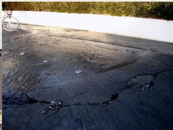
断水(水道管破損による漏水)
