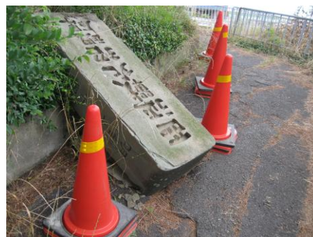
図 8-3 大阪府北部地震の被害
