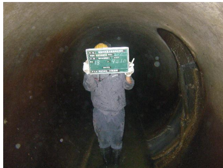
【管内踏査状況】
