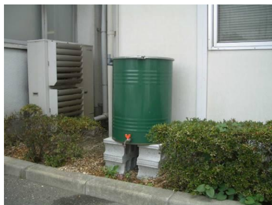
雨水タンク（市役所本館）
