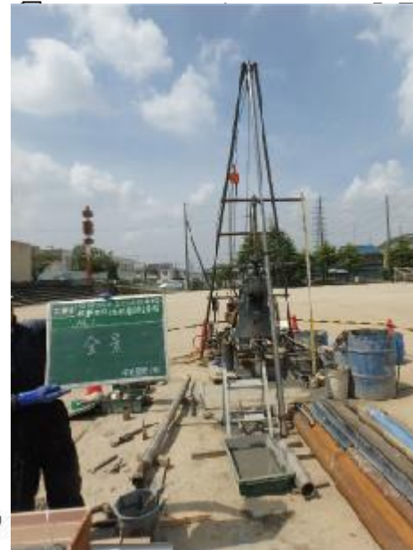
ボーリング状況
