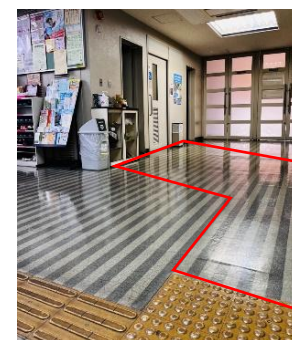
点字ブロックの敷設
