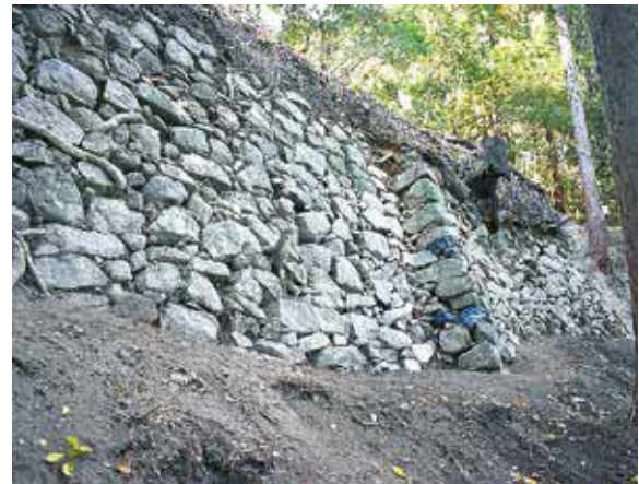
出角のある石垣 (石垣 69)
