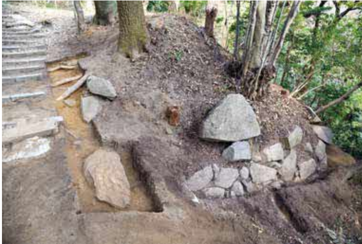
虎口 石垣 30 南西から
