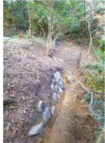
石垣 30 (曲輪 99 東斜面)
