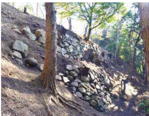
石垣 6・7 北西から
