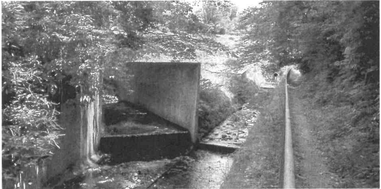
写真② 古池の洪水吐と底樋からの水が形成する権現川の水源
