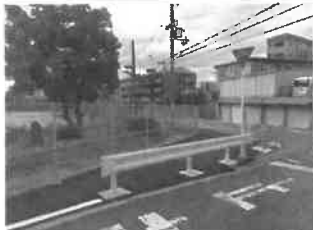
旧南中東北角の通学路の安全対策。歩道拡幅と車止めボールの設置工事。
