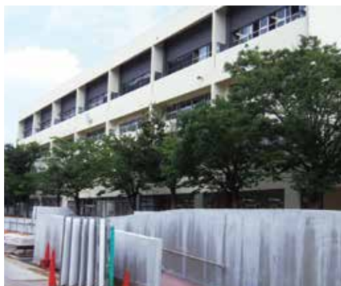
校舎の工事が終わり、体育館とプールの改築を進める西中の様子
