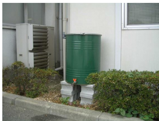
雨水タンク（市役所本館）
