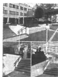
市民総合センター 正面階段の手すり設置
