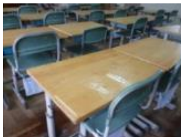
教室内の雨漏り
