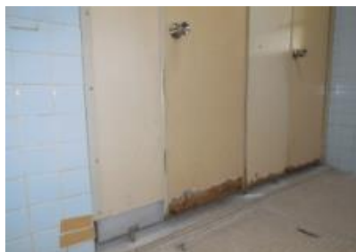
トイレ扉の腐食
