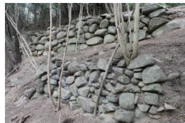
2段に積まれた石垣
