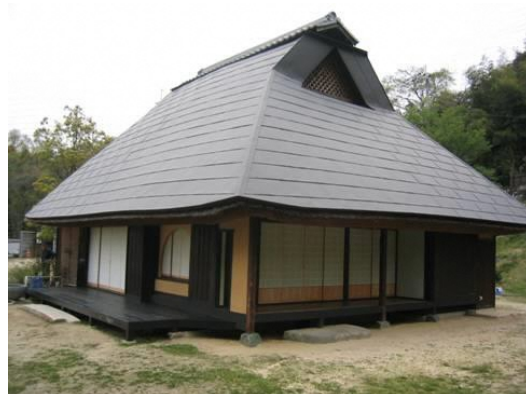
市立環境センター修景施設内の管理棟
