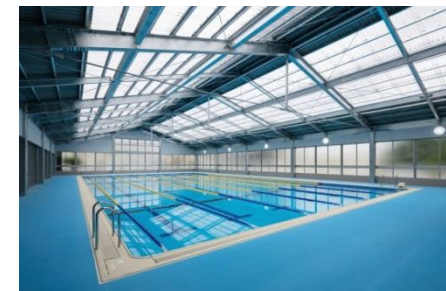
プール棟新築（西中学校）
