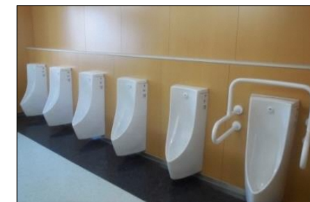
四條畷中学校校舎内トイレ改修
