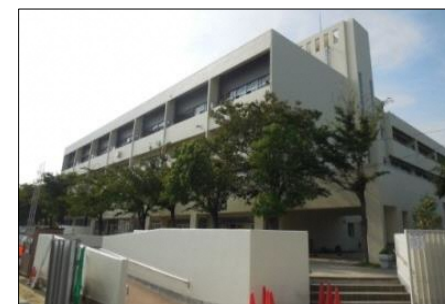
四條畷西中学校校舎大規模改修
