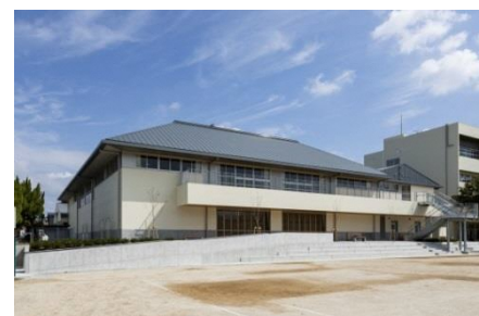
体育館新築（西中学校）
